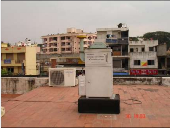
Amco Batteries, Mysore Rd, B'lore
